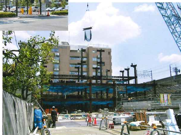
西館新築工事
