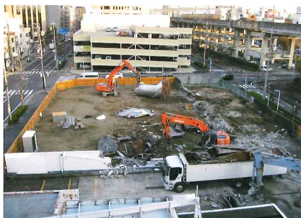
ガソリンスタンド解体
